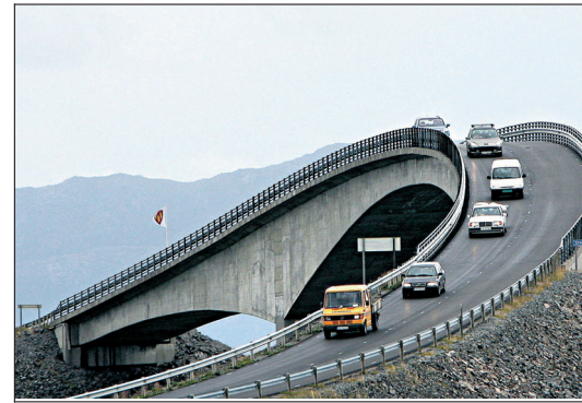
Totalt har Riksantikvaren fredet 40 veier her til lands. Bildet viser Atlanterhavsveien.
